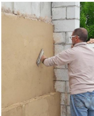
Foto B – Finisare cu stuc exterior termoizolant CANAPASTUCK.
